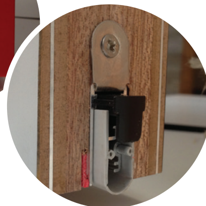
Détail: seuil tombant automatique.
